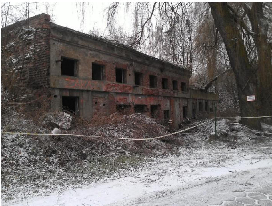
Fot. 2 Elewacja zachodnia - brak stolarki, uszkodzenia ścian zewnętrznych
