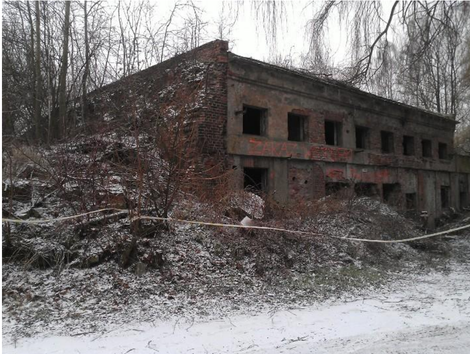
Fot. 1 Elewacja zachodnia z widoczną częścią muru zawalanej części budynku
