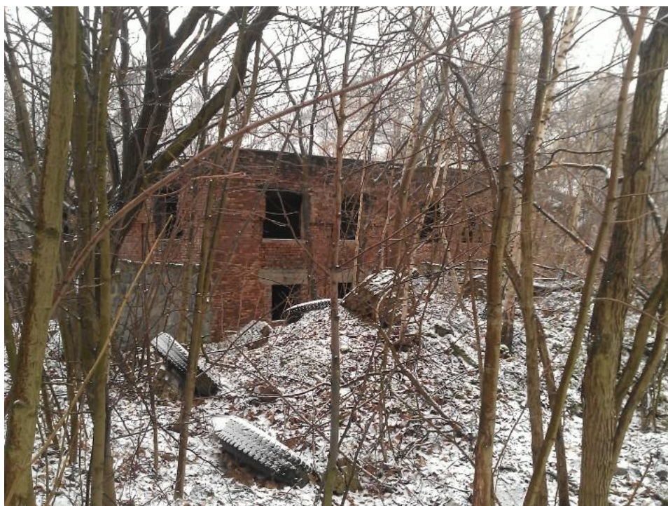
Fot. 10 Elewacja północna - brak stolarki okiennej, uszkodzona ściana zewnętrzna
