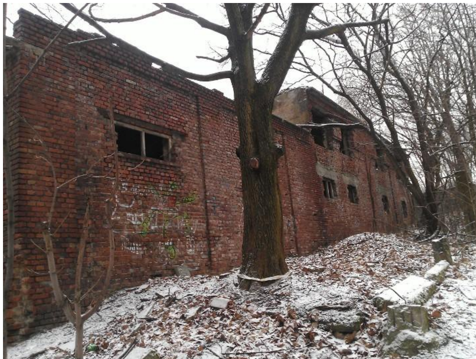
Fot. 7 Elewacja wschodnia - brak stolarki okiennej, uszkodzona ściana zewnętrzna
