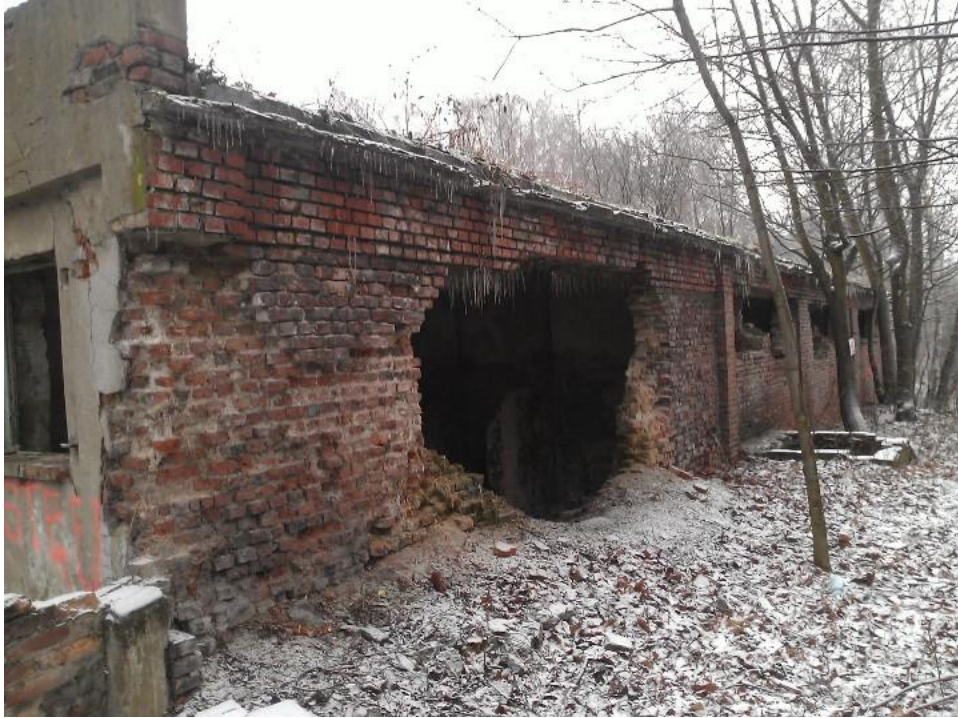
Fot. 5 Elewacja południowa - wielka wyrwa w ścianie zewnętrznej, pocieniona ściana zewnętrzna
