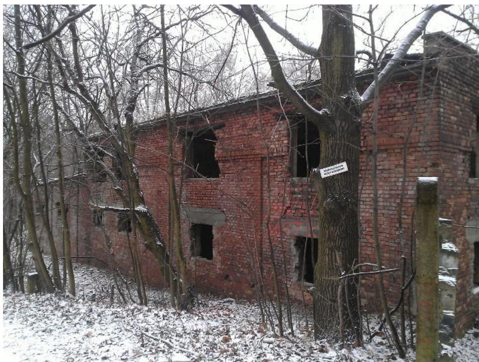
Fot. 8 Elewacja wschodnia - brak stolarki okiennej, uszkodzona ściana zewnętrzna
