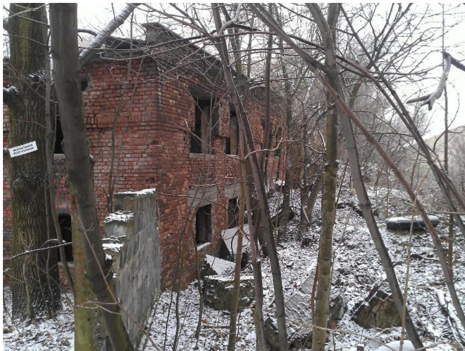
Fot. 9 Elewacja północna - brak stolarki okiennej, uszkodzona ściana zewnętrzna
