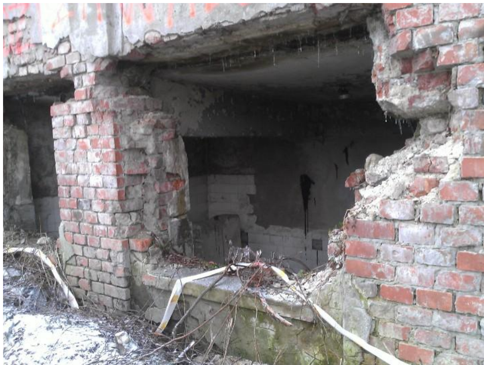
Fot. 3 Część ściany zewnętrznej zachodniej - uszkodzenia ściany, brak stolarki
