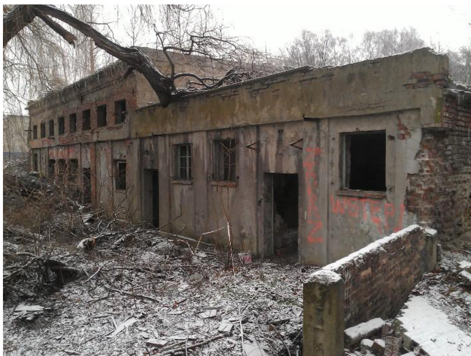
Fot. 4 Elewacja zachodnia - uszkodzenia ściany, brak stolarki, przewrócone drzewo na dach
